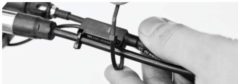
Figura 13: Instalación del Cajetín de conexiones del conmutador
