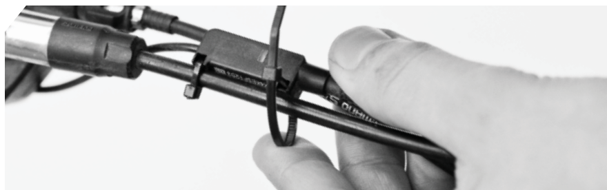
图 13：安装转换开关接线盒
