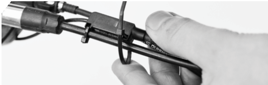
Abbildung 13: Anbringen des Schalteranschlusskastens
